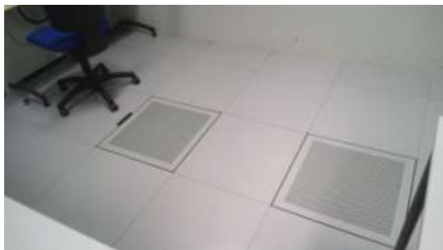
Soufflage depuis le plancher technique
