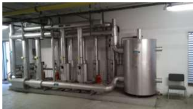
Distribution hydraulique depuis la chaufferie
