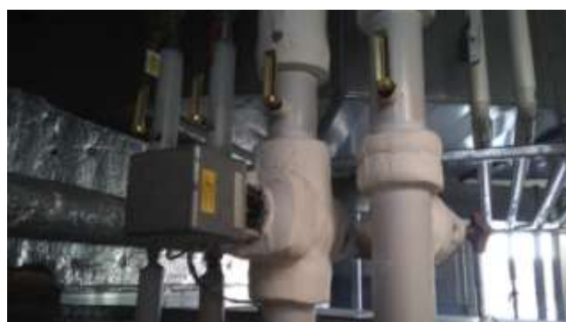
Vanne 3 voies batterie EG de la CTA
