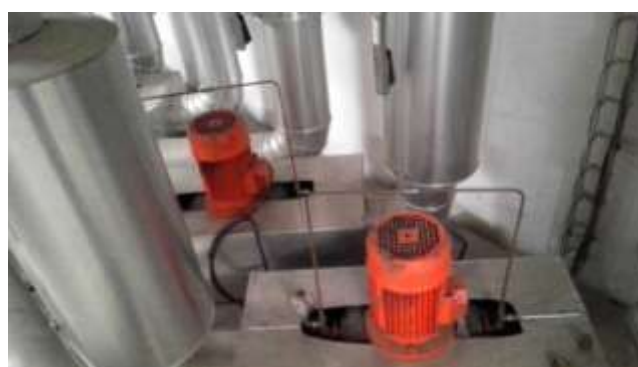
Réseau fermé entre les armoires et les condenseurs
