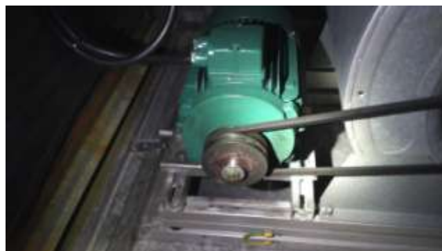
Absence d'une courroie sur moteur Du ventilateur CTA Amphi 200
